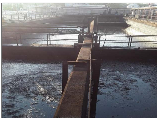
ภาพที่ 2.2-9 API Separator ที่สถานีผลิตลานกระบือ
