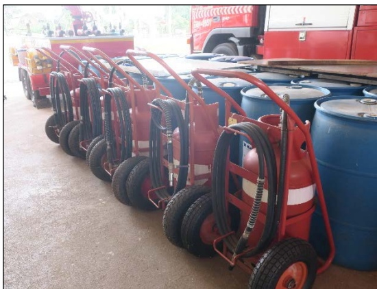
ภาพที่ 2.2-7 อุปกรณ์ดับเพลิงและขจัดคราบน้ำมันที่สถานีผลิตลานกระบือ (LKU Flow Station)
